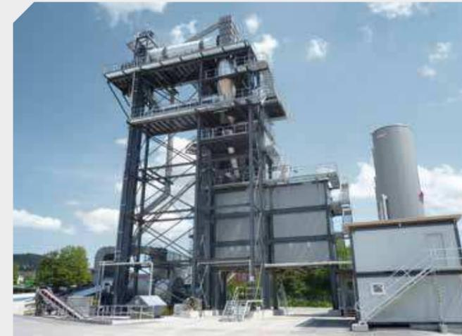
Nachträgliche Erweiterung der Anlage um ein Heißrecycling-Zugabesystem. Mit der Technologie der Paralleltrommel kann eine Zugaberate von bis zu 70 % erreicht werden.
