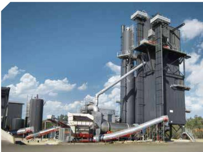
Les centrales d'enrobage peuvent être dotées d'un système d'adjonction de matière recyclée à froid ou en être équipée ultérieurement. Les variantes d'adjonction multivariable permettent d'atteindre une part de matière recyclée allant jusqu'à 40 %, tout en préservant parfaitement les matières et composants.
