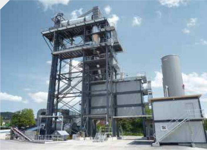
Extension ultérieure de l'installation au moyen d'un système d'adjonction de matière recyclée à chaud. Grâce à la technique du tambour parallèle, le taux d'adjonction peut également atteindre jusqu'à 70 %.
