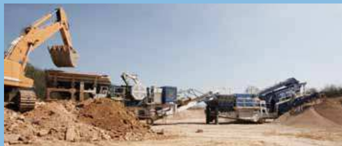
Материал на MCO 9 S подается непосредственно с мобильной дробильной установки со щековой дробилкой MOBICAT MC 120 Z.
